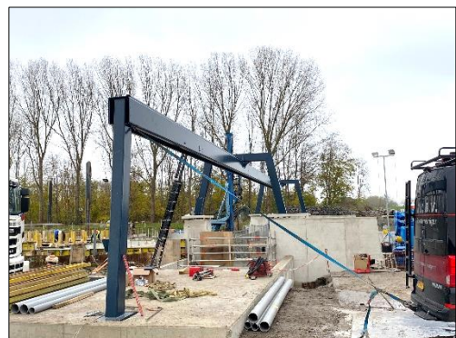
Beeld van de aangebrachte krooshekreiniger
