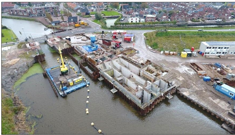
Beeld van de bouwkuip van het nieuwe gemaal (rechts) en de bouwkuip voor de nieuwe schutsluis (links)
